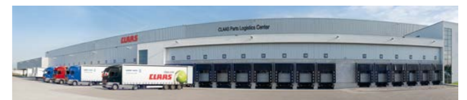
Das CLAAS Parts Logistics Center in Hamm, Deutschland, verfügt über 155.000 verschiedene Teile auf mehr als 100.000 m 2 Betriebsfläche.
