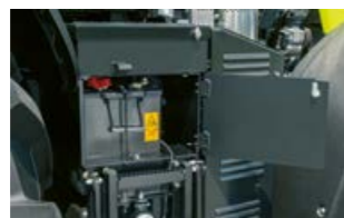
La batteria è posizionata ben accessibile a destra della scaletta per salire in cabina.
