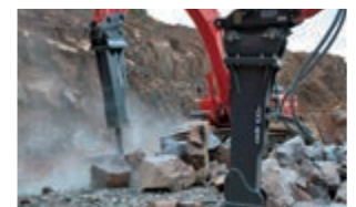
Doosan brekers en snelkoppelingen Doosan levert sterke, betrouwbare uitrustingen voor sloopwerkzaamheden.
