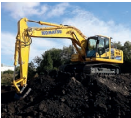
Eccezionali forze di scavo
