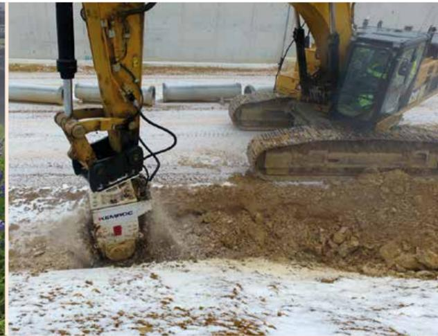
▲ Mit dieser **EK140** werden Gräben für Drainageleitungen direkt am Böschungsfuß einer neuen ICE-Trasse gefräst.
