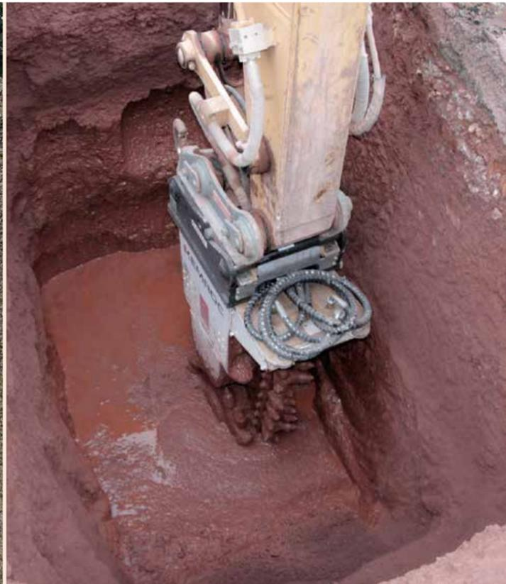
▲ Diese **EK100** Kettenfräse arbeitet in abrasivem Sandsteinschlamm und fräst Kopflöcher aus. Angebaut wurde die Fräse an einem 23 t schweren CAT 323 D. Die Fräsleistung im 30 bis 50 MPa harten Sandstein beträgt 7 bis 10 Kubikmeter pro Stunde.
