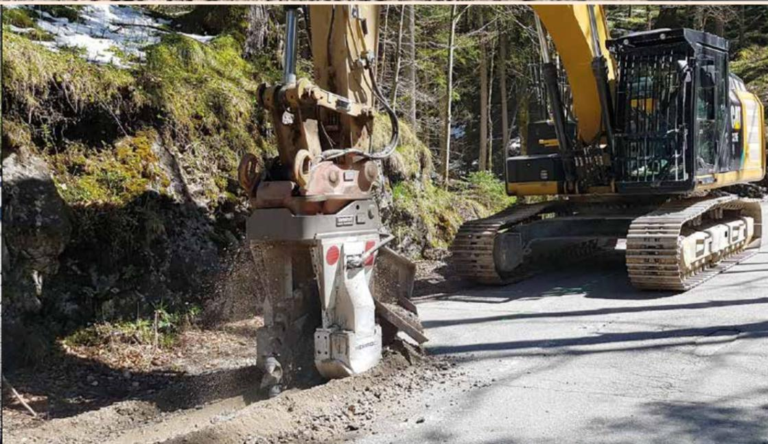
▲ Im Schiefergestein fräst diese Kettenfräse **EK 100** souverän einen 70 cm breiten und 1,2 m tiefen Kanalgraben.
