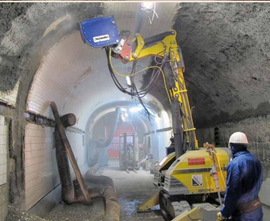
▲ Dieses **DMW130** am Liebherr Tunnelbagger schneidet in vorgegebenen Abständen ein Tunnelprofil umlaufend ein, um dort später Kontrolldrainagerohre und Dammringe zu verbauen.
