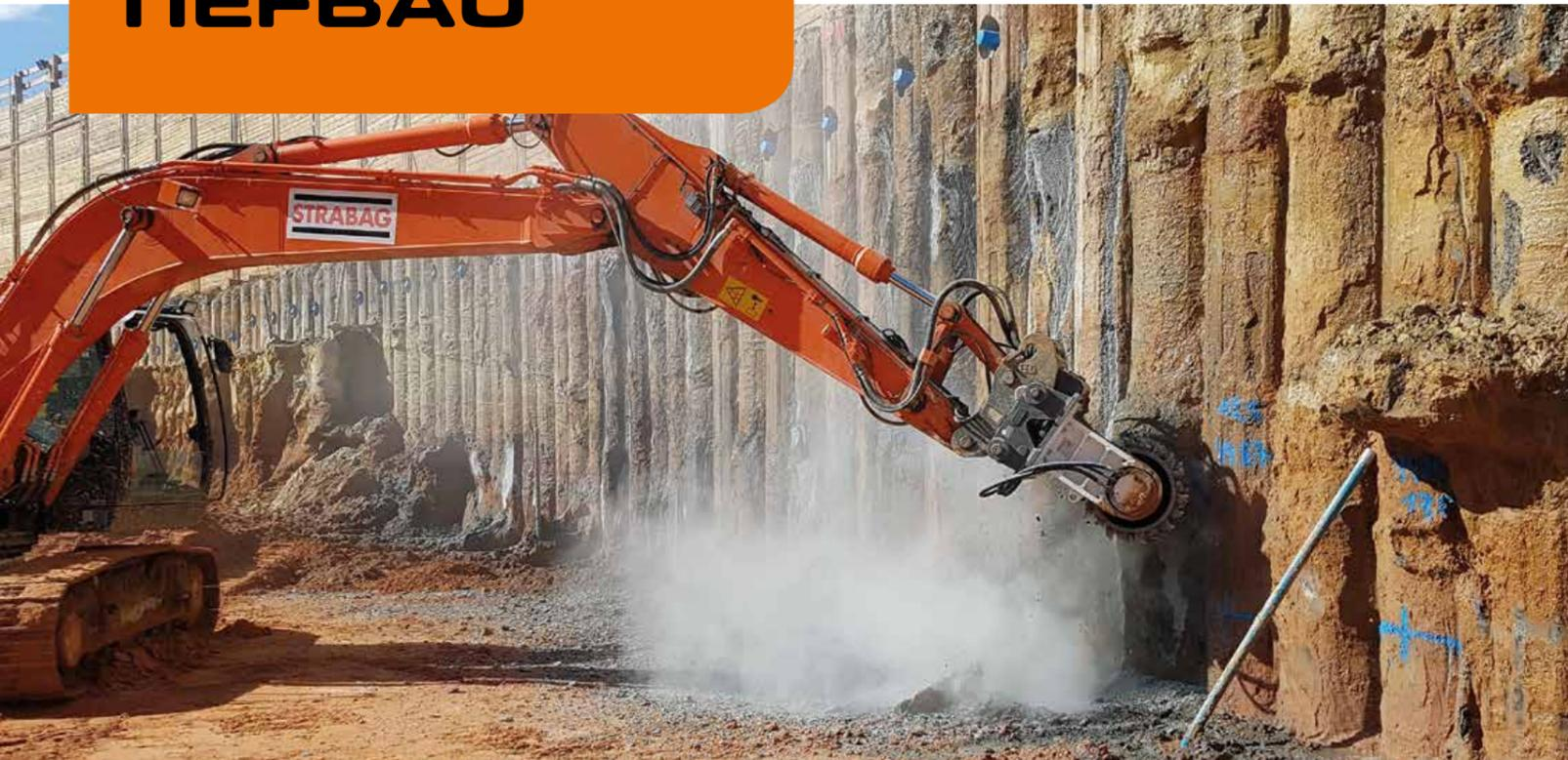
▲ Der überstehende Beton dieser Bohrpfehlwand wird schnell und präzise abgefräst. Hierbei kommt eine **ES60HD** mit Frästrommel zum Einsatz.
