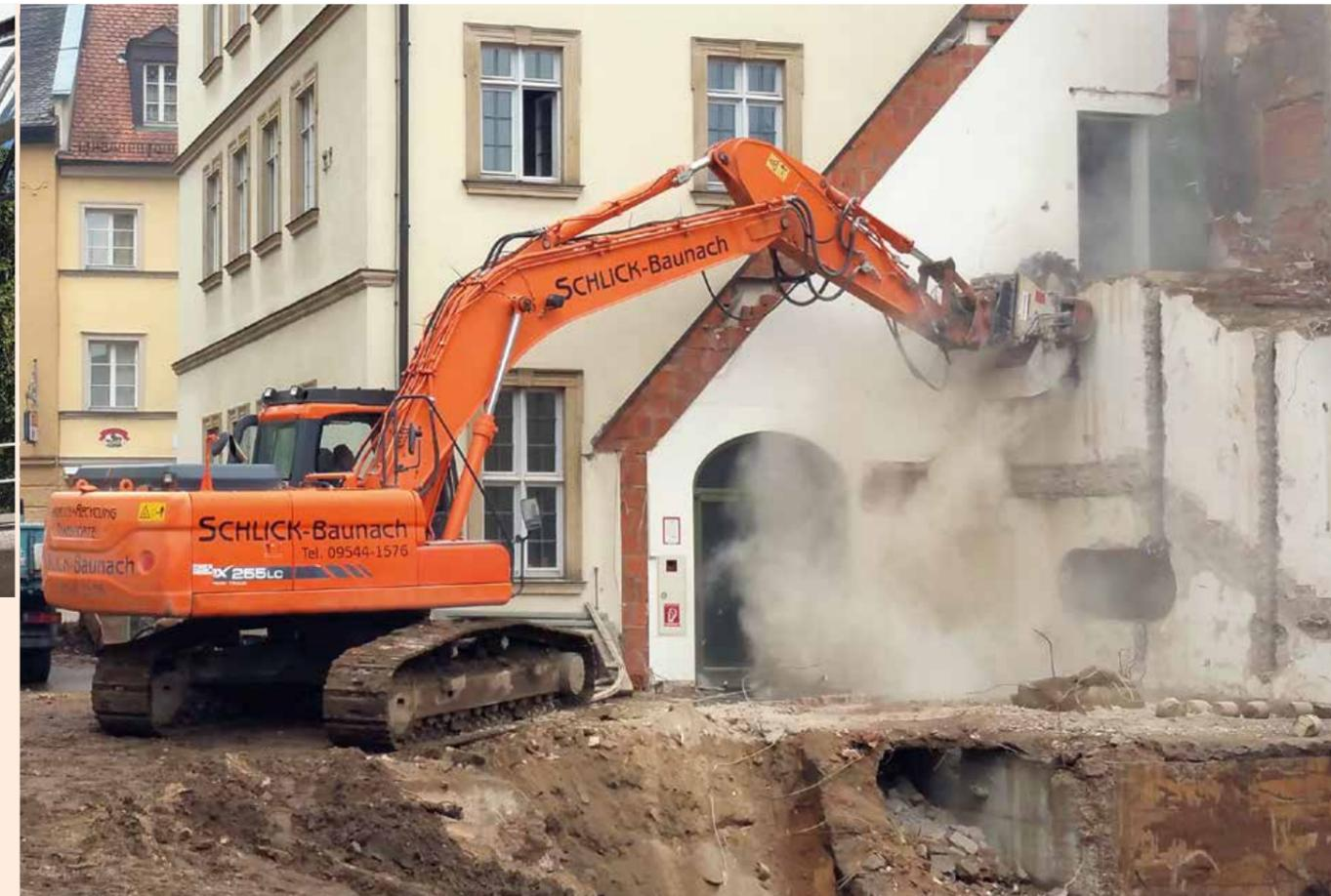
▲ Erschütterungarmer Teilabbruch eines Gebäudes mit einem **DMW130** Schneidrad. Hierbei können unter anderem Teilwände abgebrochen werden, ohne die historische Bausubstanz zu beschädigen.
