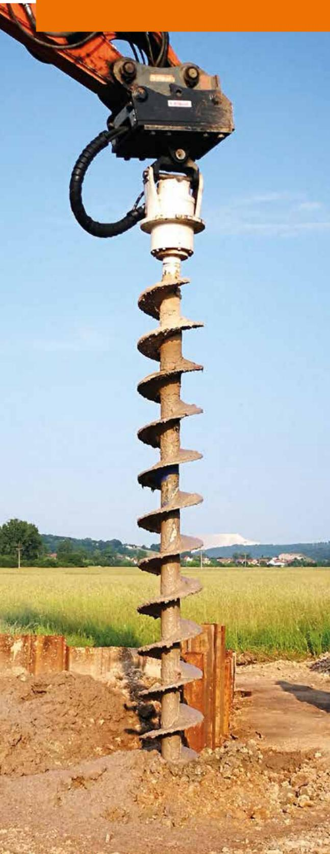
◀ Mit einer **EBA 2300-D** wird der mittelharte Boden bis zu einer Tiefe von 6 Metern durch Bohren aufgelockert, damit anschließend die Spundbohlen leichter in den Boden gerammt werden können.
