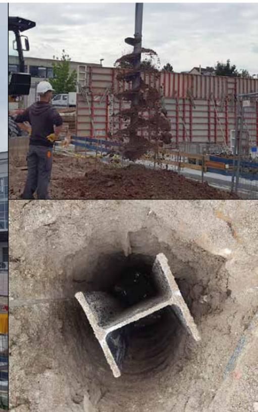
▲ Hier bohrt eine **EBA 2300-D** 5 m tiefe Löcher zum Einsetzen von Stahlträgern, die zur Herstellung eines Berliner Verbaus benötigt werden.
