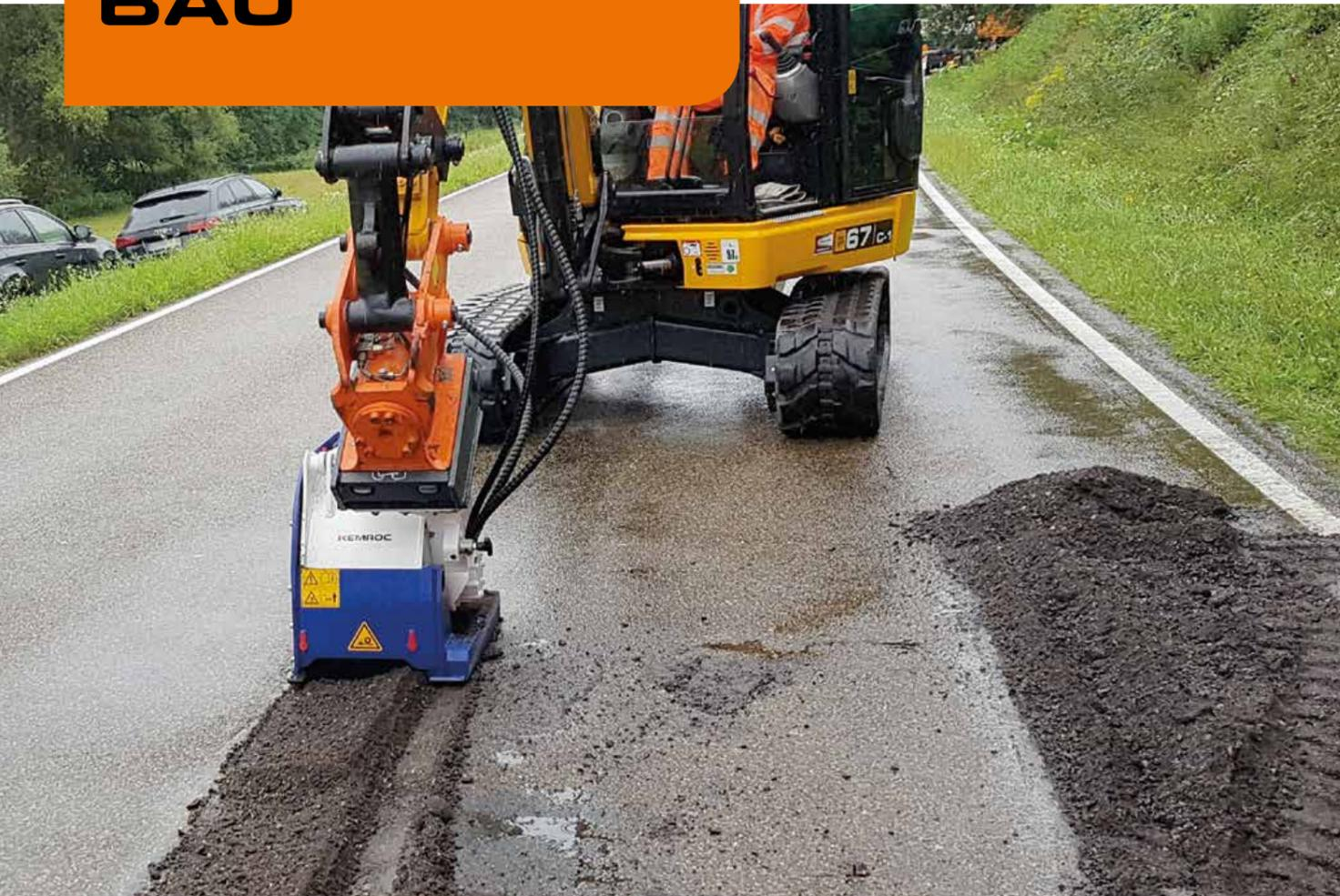
▲ Diese **EX20HD** arbeitet an einem Takeuchi TB 235 und fräst Asphalt mit einer Tiefe von 3 cm. Die Fräsleistung beträgt 25 m<sup>2</sup> pro Stunde. Mit KEMROC Flächenfräsen der Serie EX werden glatte Schnittkanten erzeugt.
