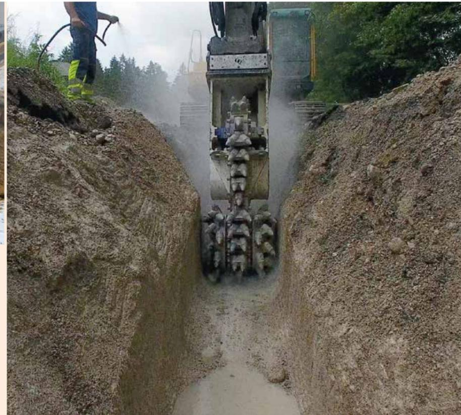
▲ Gewaltige Fräsleistung im schmalen Graben. Diese **EK100** mit 700 mm breitem Schneidkopf fräst knapp 15 m Graben in einer Stunde. Dank der umlaufenden Fräskette muss die Fräse nicht seitlich geschwenkt werden, um zu arbeiten. Das schont den Bagger und spart Energie, die für das Fräsen verwendet werden kann.
