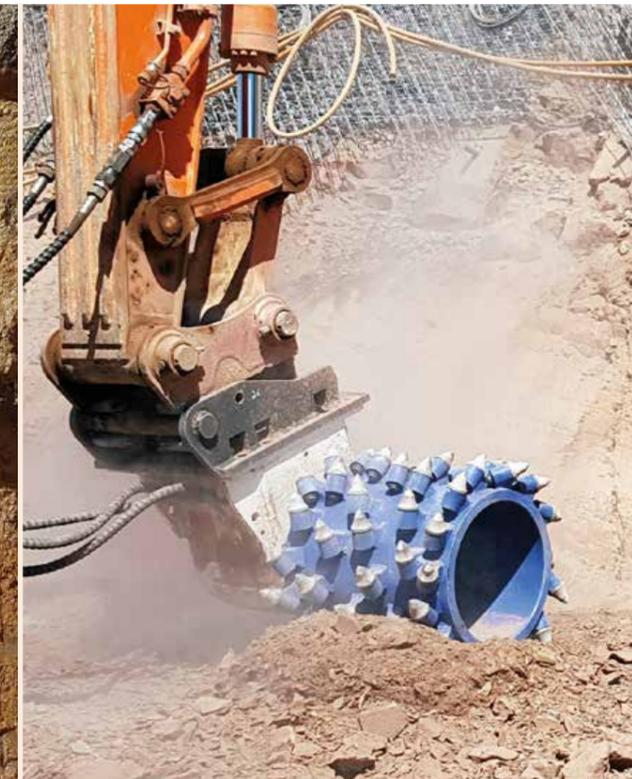
▲ Mit dieser **ES80HD** wird eine Böschung aus Sandstein gefräst. Die 80 cm breite, zylindrische Trommel ist das ideale Werkzeug, um den Hang exakt zu profilieren.
