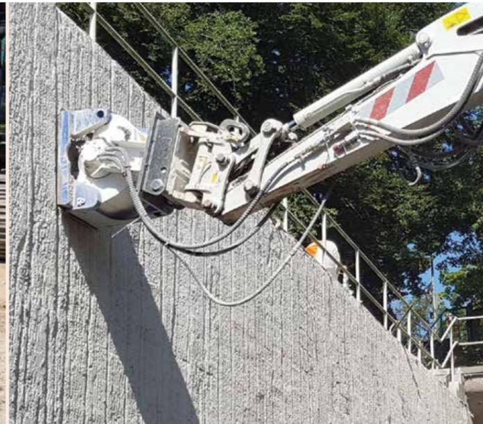
▲ Diese **DMW220** durchtrennt mit einer Geschwindigkeit von 1,5 m/min eine 60 cm dicke Betonplatte. Der Beton ist mit Bewehrungstäählen von 16 bis 25 mm bewehrt. Alle Stähle werden von dem Schneidrad mühelos zerrissen.
