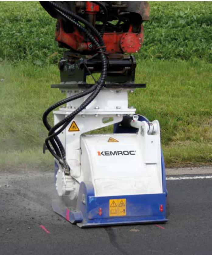
◀ Hier wird mit einer **EX45HD** eine Asphaltdecke 4 cm abgefräst. Durch den verbauten Rotator ist es möglich, quer zur Fahrbahn zu fräsen.
