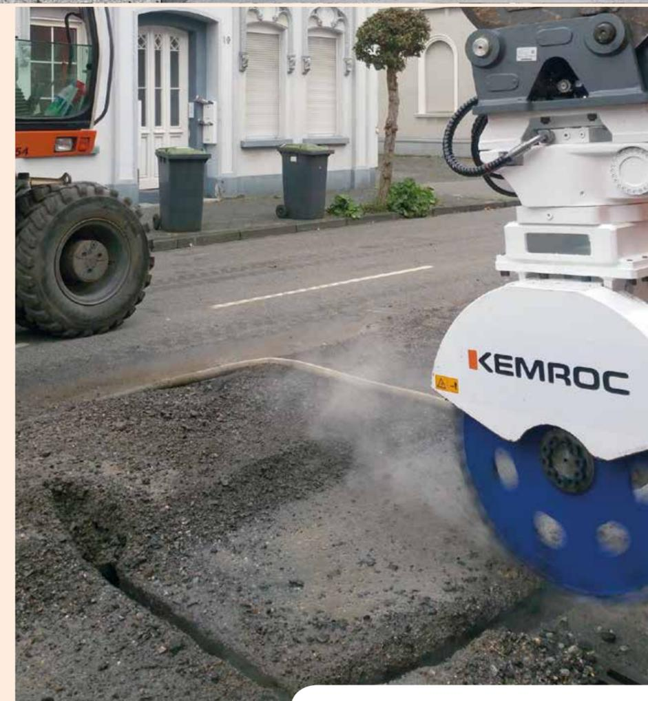
► Eine **ES60HD** mit Rotator, angebaut an einen Liebherr A 900 Radbagger durchtrennt eine 30 cm dicke Asphaltdecke. Die Frägeschwindigkeit beträgt 2 m/min.
