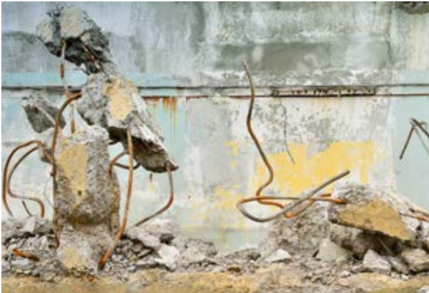
Hormigón de demolición
