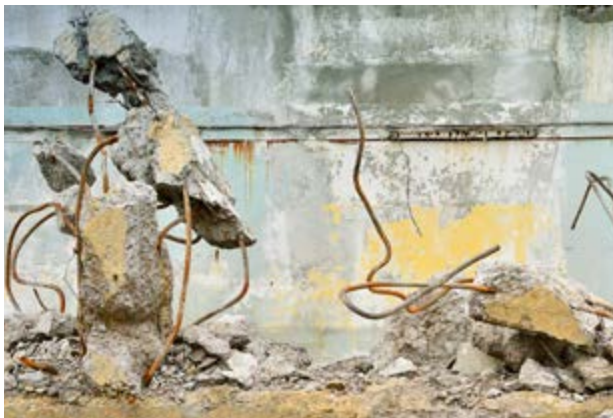
Снос бетонных конструкций
