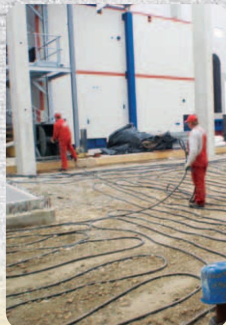
Шаг 1: В зависимости от уровня температуры перед обработкой грунт необходимо разморозить и нагреть. E 700M от Wacker Neuson позволяет значительно ускорить процесс.
