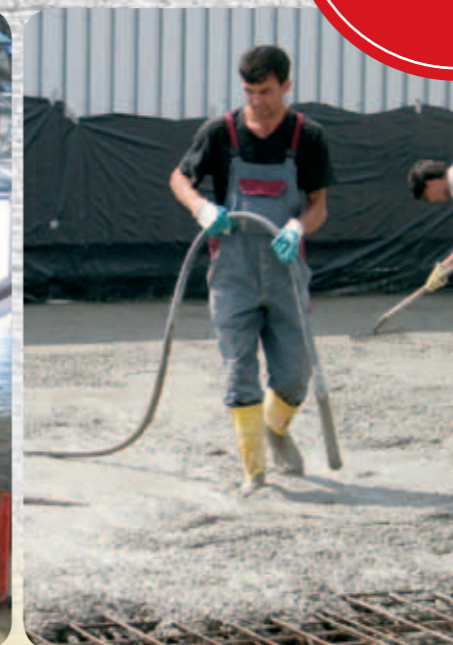
Шаг 6: После этого бетон необходимо уплотнить. Таким образом он приобретает первоклассное качество. Для этой цели предлагается широкий ассортимент глубинных вибраторов Wacker Neuson.
