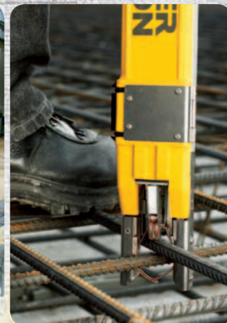
Шаг 4: Устанавливается арматура и обрабатывается с помощью инструментов Wacker Neuson для вязки и резки арматуры.
