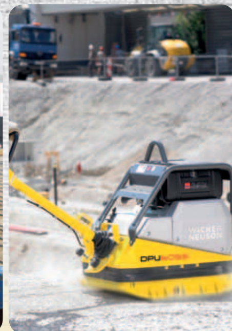
Шаг 2: Грунт подготавливается и перед дальнейшей обработкой уплотняется. Wacker Neuson предлагает широкий ассортимент виброплит в зависимости от величины обрабатываемой площади.
