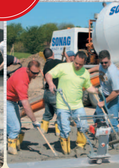
Шаг 7: Использование виброрейки гарантирует ровность бетонной поверхности и соблюдение необходимого уровня по высоте. В результате бетон оптимально подготовлен для обработки заглаживающими машинами.
