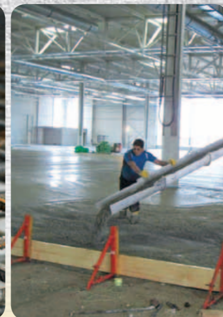
Шаг 5: Подается и заливается свежий бетон.
