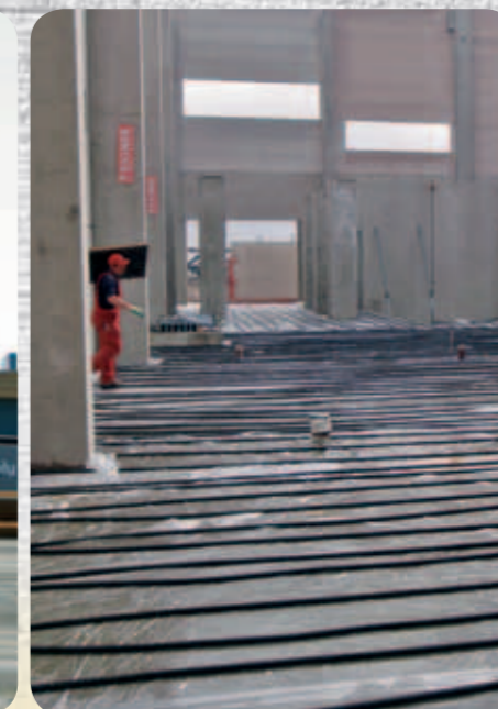
Шаг 9: Дополнительная обработка предотвращает преждевременное охлаждение и высыхание бетона во время его затвердевания. Для решения этой задачи оптимально подходит устройство для прогрева почвы E 700M от Wacker Neuson, гарантирующее равномерность процесса схватывания благодаря прогреванию большой площади.
