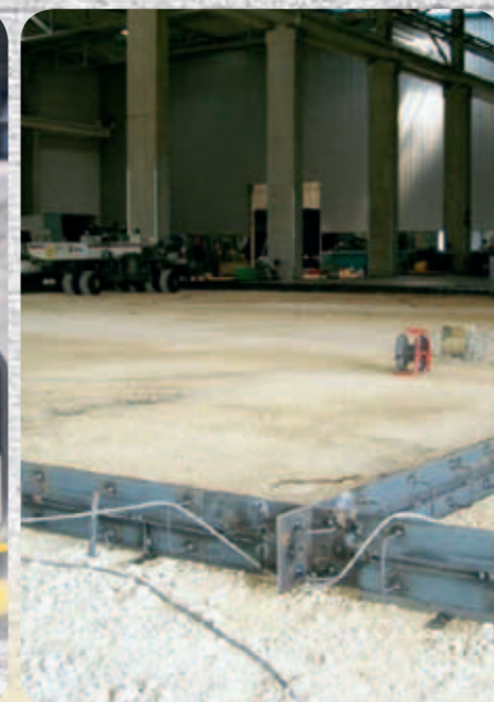
Шаг 3: Устанавливаются ограничители обрабатываемой площади.
