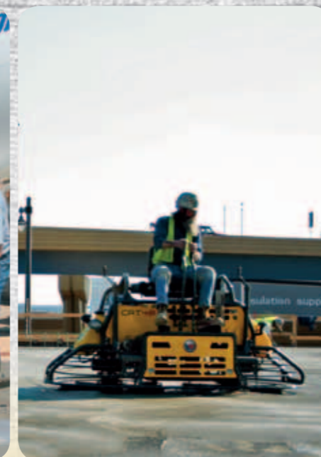
Шаг 8: Для придания поверхности ровности и гладкости применяются заглаживающие машины: сначала она затирается, затем зачищается начисто и в заключении полируется.
