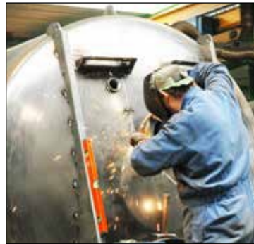
Soldadura manual de los accesorios
