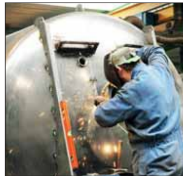
Soudure manuelle des accessoires
