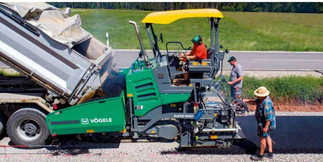
Die Antriebsstation des SUPER 1000i erfüllt mit einem Dieseloxydationskatalysator (DOC) und einem Dieselpartikelfilter (DPF) zur Abgasnachbehandlung die strengen Richtlinien der europäischen Abgasstufe V und der US-Norm EPA Tier 4f.
