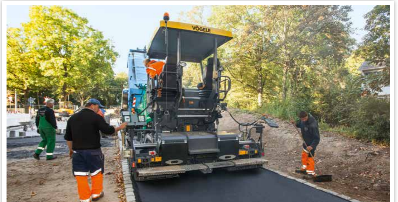
WEGEBAU IN PARKANLAGEN
