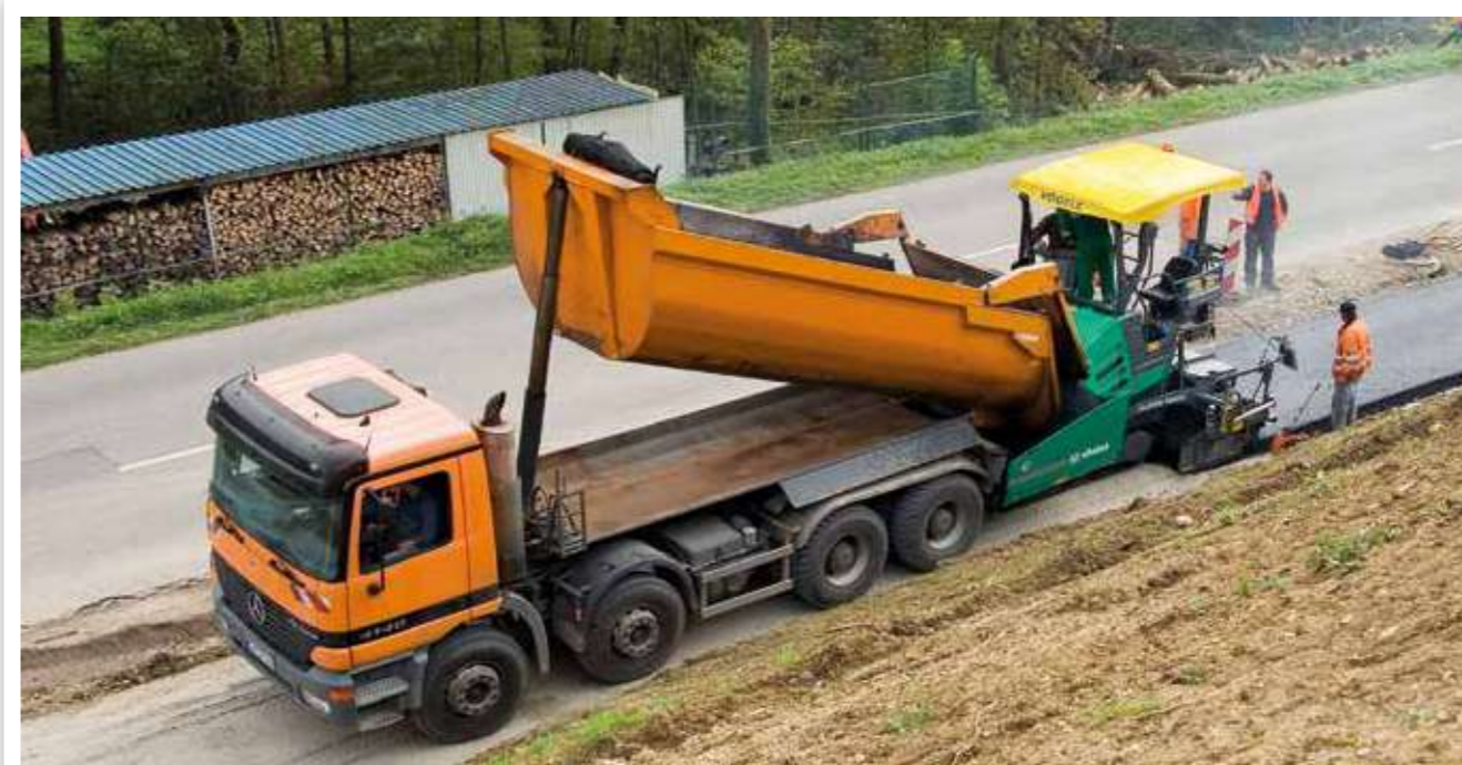
POSE D'ENROBÉ SUR TROTTOIRS/PISTES CYCLABLES COMBINÉS
