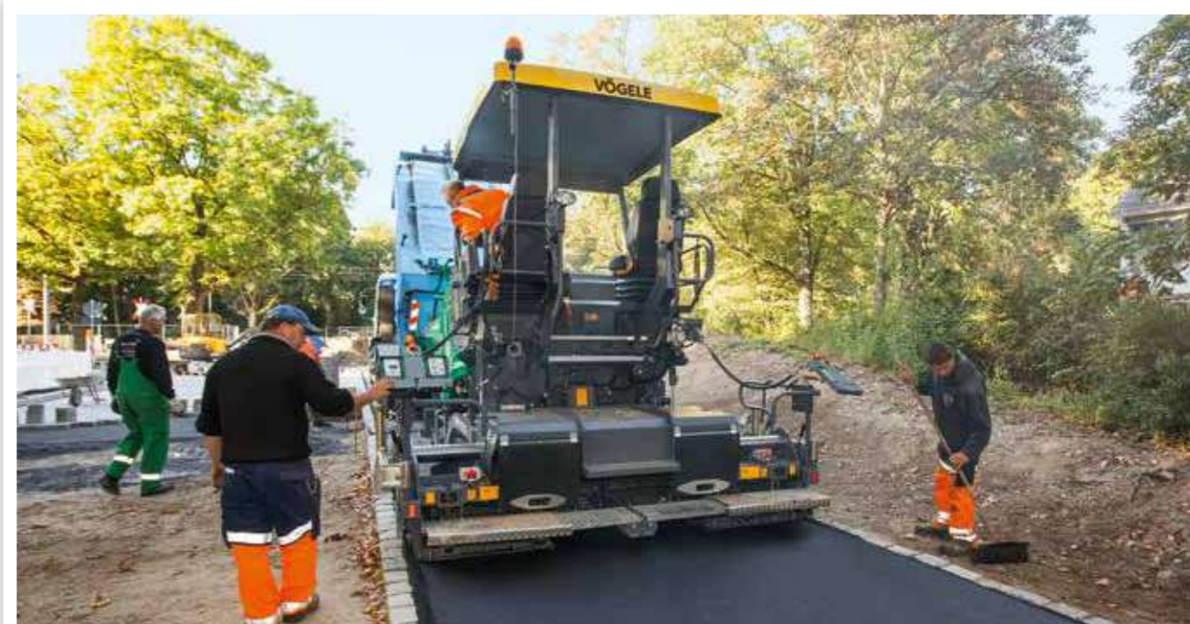
CONSTRUCTION DE CHEMINS EN ESPACES VERTS
