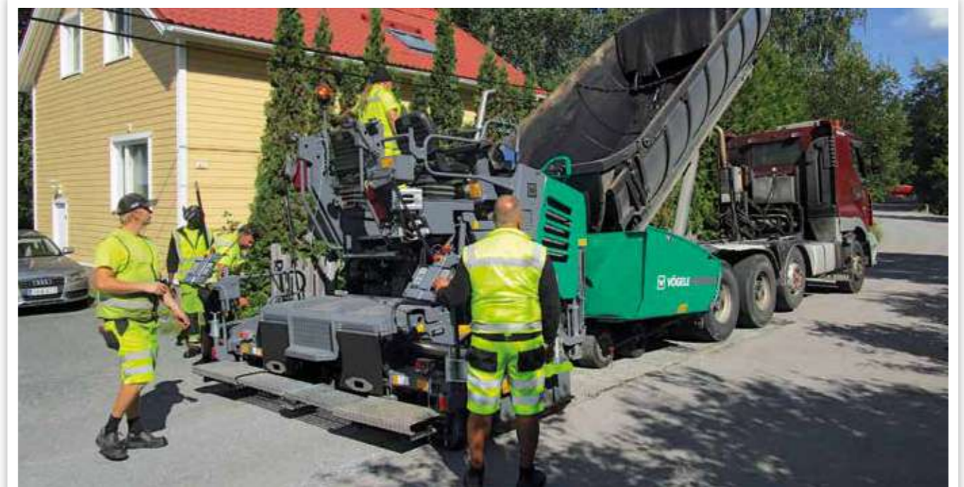
REHABILITACIÓN DE CARRETERAS MUNICIPALES
