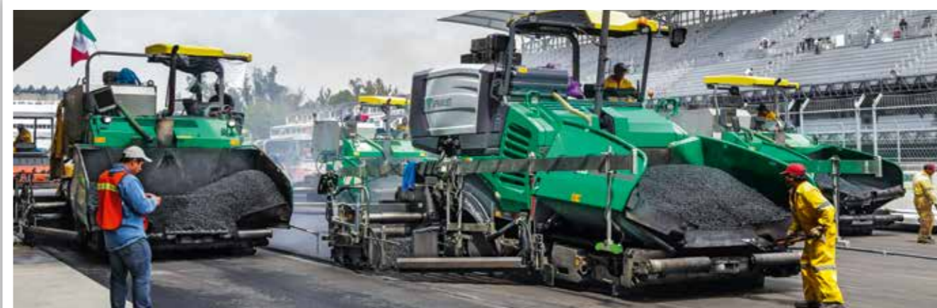
REHABILITACIÓN DE UNA PISTA DE CARRERAS
