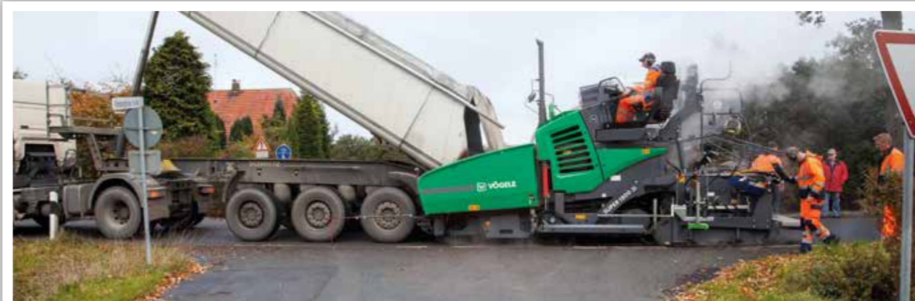
REHABILITACIÓN DE UNA CARRETERA EN UN ÁREA RESIDENCIAL
