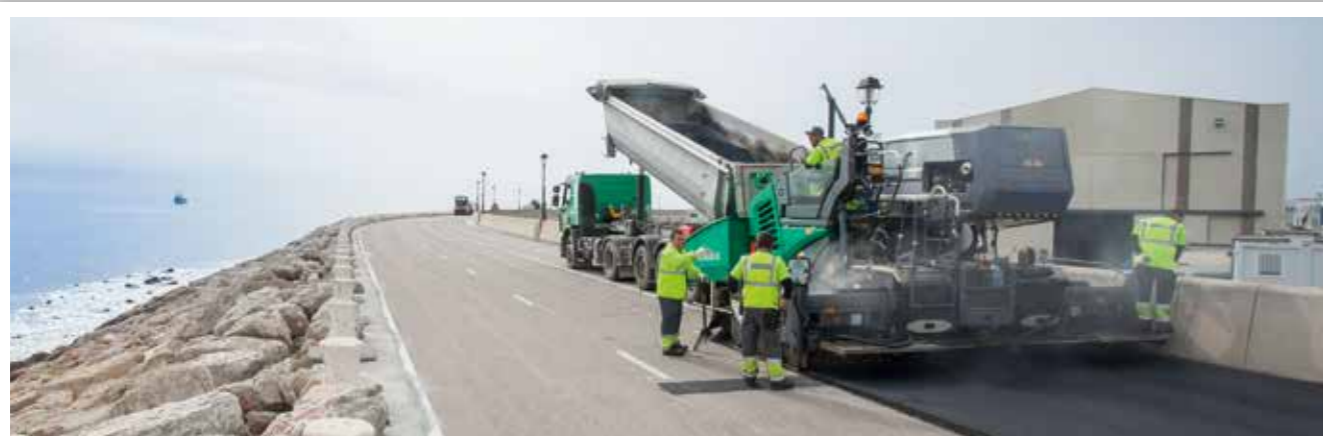
REHABILITACIÓN DE UNA CARRETERA SOBRE UN DIQUE DE CONTENCIÓN
